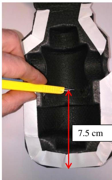
**2** - Intagliare il guscio di isolamento termico, a partire da una distanza pari a 7,5 cm dal bordo inferiore del guscio stesso, come indicato in figura.
